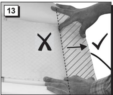
13. Die Heizmatten dürfen auf keinen Fall in Längsrichtung geschnitten werden
